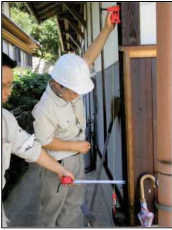
◀家の傾斜を測定している写真の例
