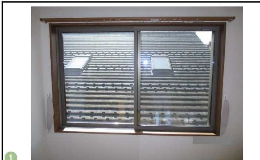
1 工事前 部屋名 2 寝室① 工事内容 3 内窓設置(中)
