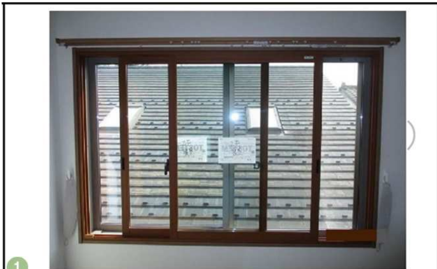
1 工事後 部屋名 2 寝室① 工事内容 3 内窓設置(中)
