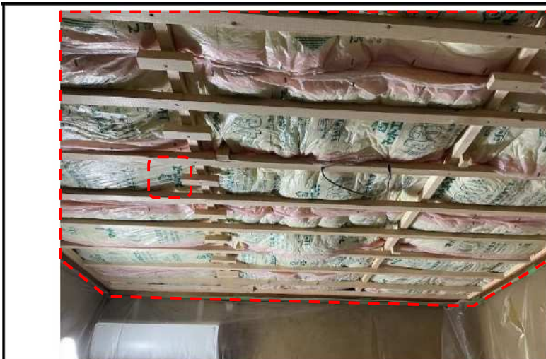
工事後 部屋名 2階和室① 工事内容 天井断熱改修
