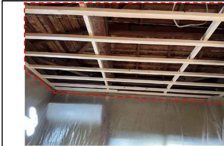
工事前 部屋名 2階和室① 工事内容 天井断熱改修
