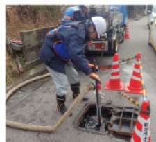
能登半島地震における石川県での復旧作業
