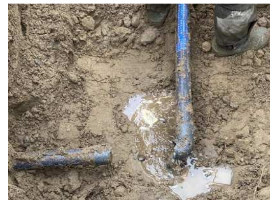
令和6年能登半島地震 管路被害 (新潟市西区寺尾上 Φ50VP)
