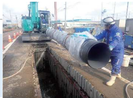
基幹管路更新工事
