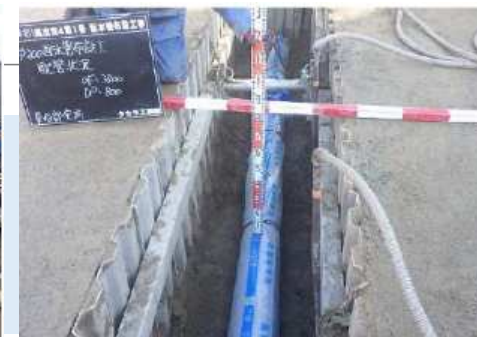
配水支管更新工事
