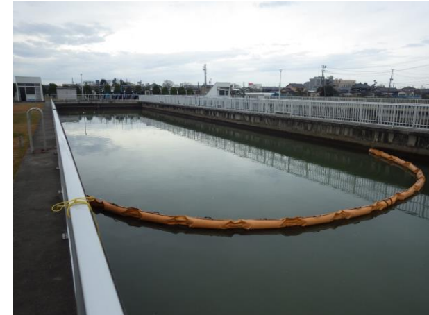
油流入を防止するオイルフェンス
