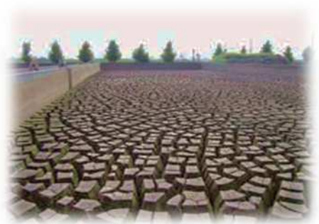
天日乾燥床(阿賀野川浄水場)
