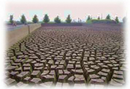
天日乾燥床(阿賀野川浄水場)
