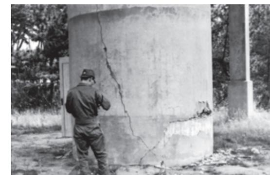
青山浄水所洗浄水槽中央コラムの亀裂 東京都水道局提供
