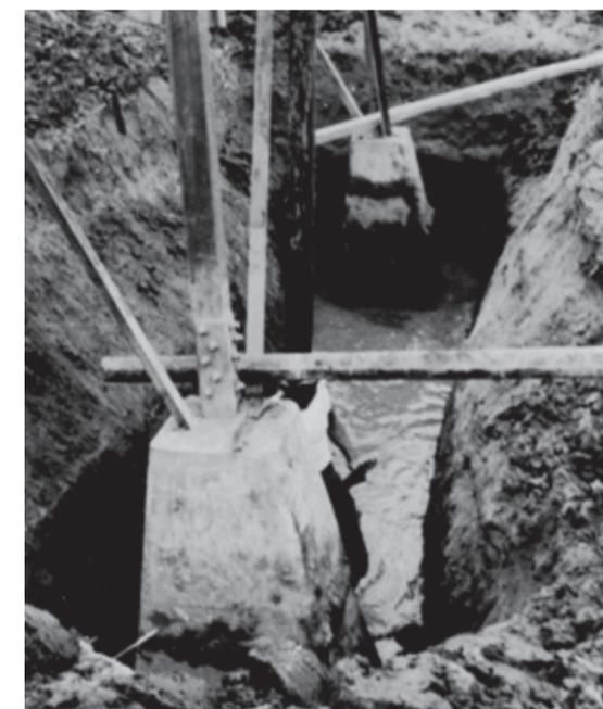
配電線鉄塔基礎の復旧工事
