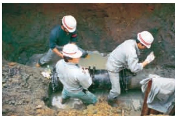
工作隊による口径350mm送水管の漏水修理
