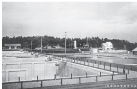
青山浄水所の沈でん池と緩速ろ過池
