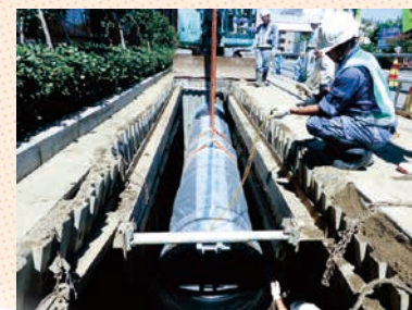
◀水道管の更新工事
