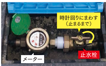
水道メーターボックス内の止水栓
