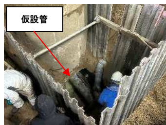
下水道管応急措置完了
