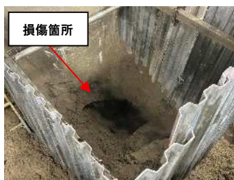
下水道管損傷状況
