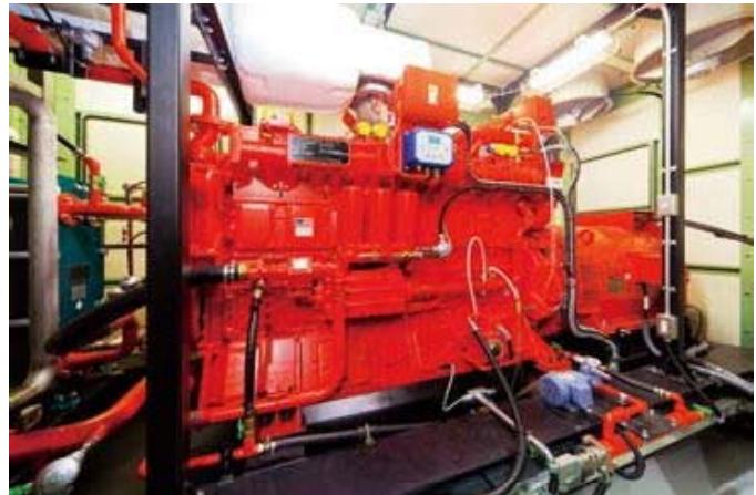
型式:水冷4サイクル電気点火式
