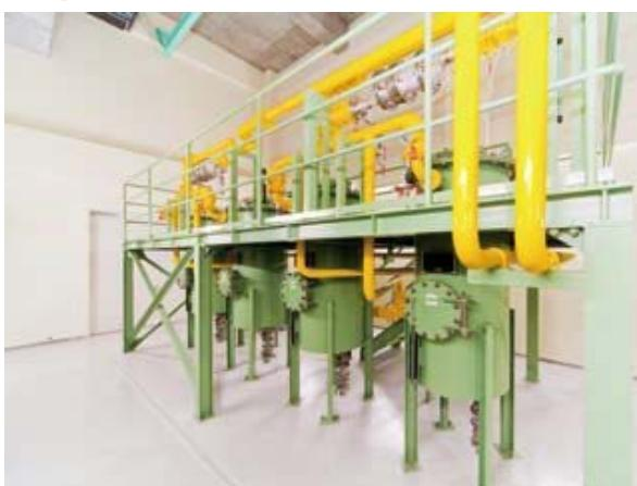
下水汚泥から発生した消化ガスには※シロキサンと呼ばれる不純物が存在します。
