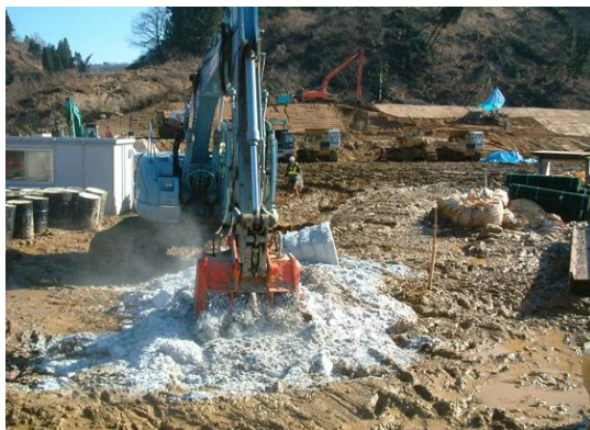
建設汚泥の改良
