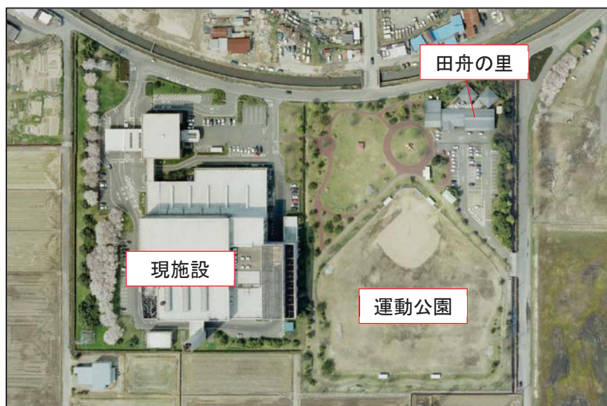
図 1.5.1 対象事業実施区域の状況
