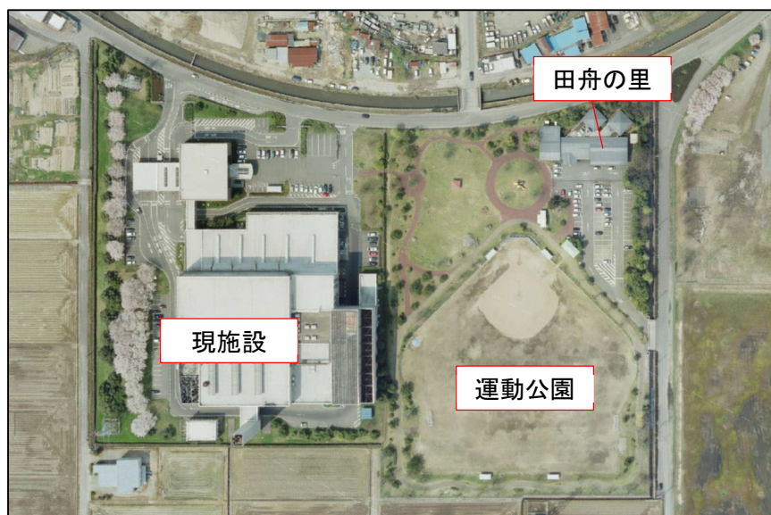
図 1.5.1 対象事業実施区域の状況
