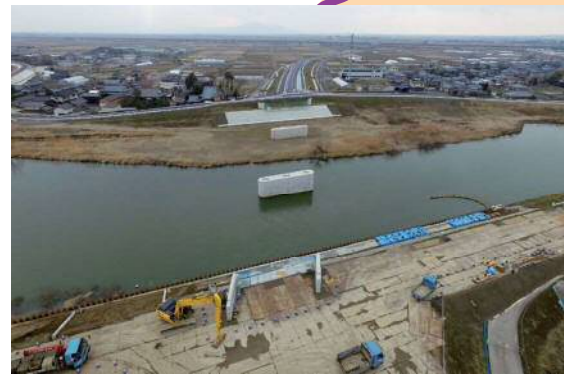
② 事業中区間 (中ノ口工区)
