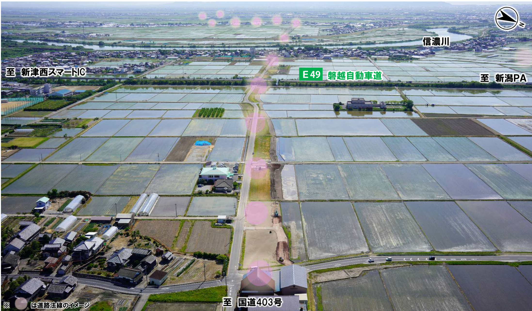
国道403号方面から信濃川方面を望む (R1.5月撮影)
