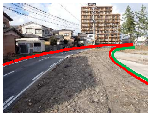
現地状況：新潟市中央区鳥屋野地先
