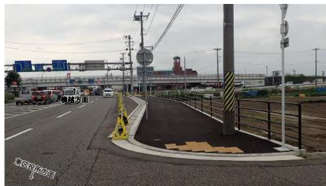
車線増加に伴う歩道移設(東区役所方面行き)
