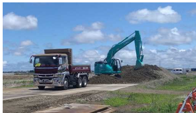
盛土作業状況
