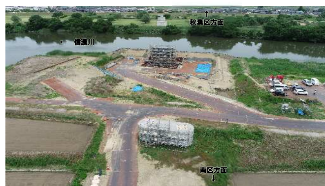
橋脚2基施工状況 新潟市南区上八枚から秋葉区横川浜を望む
