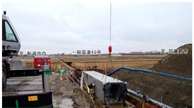
道路横断排水路ボックス設置状況
