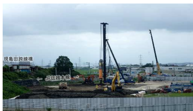
新橋ルート的基础地盤改良状況
