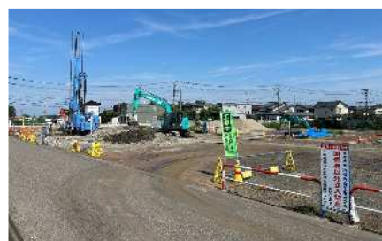
地盤改良工事 (固結工)
