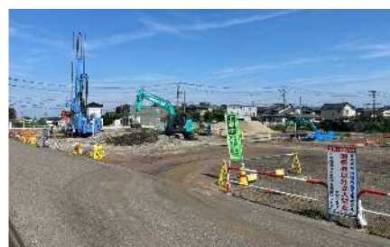
地盤改良工事 (固結工)
