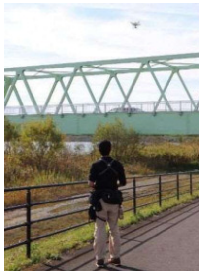
写真 2-6.5 ドローン点検の様子
