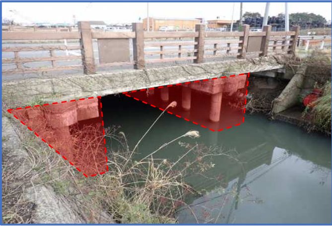
橋脚部補修範囲
