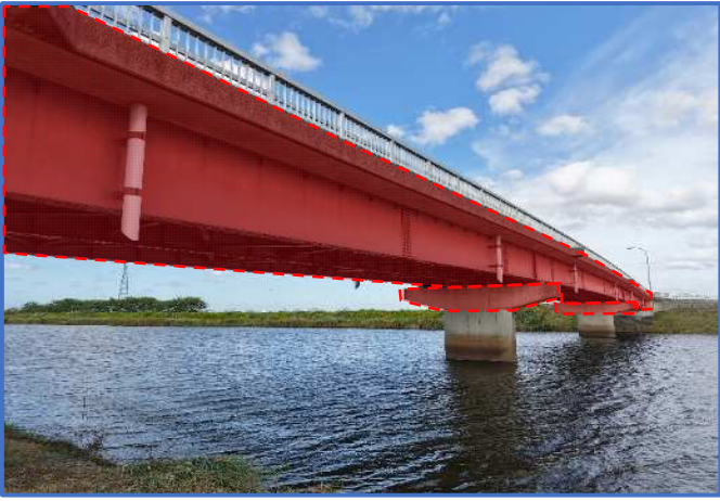
桁部、下部工部補修範囲 (塗装塗替工、補修工)
