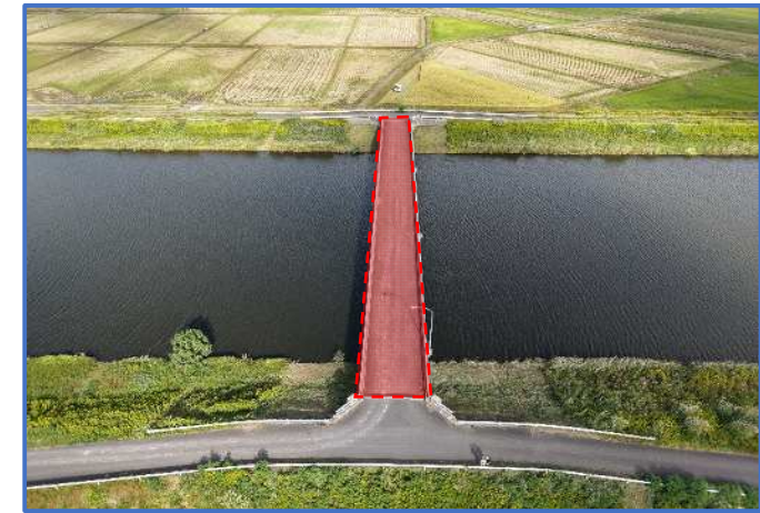
橋面部補修範囲 (舗装工)
