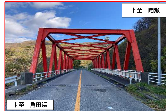
一般国道402号(浦浜大橋上)
