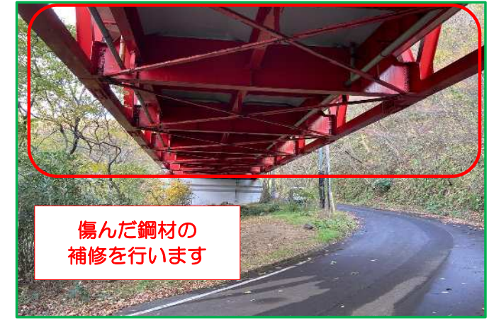
市道2-207号線(浦浜大橋下の市道)
