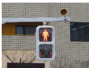
写真 44 音響式信号機の設置
