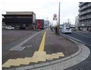
写真 37 視覚障害者誘導用ブロックの設置
