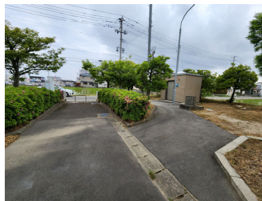
写真 40 園路の段差解消
