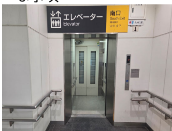
写真 33 エレベーターの設置
