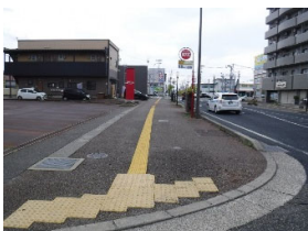
写真 37 視覚障害者誘導用ブロックの設置
