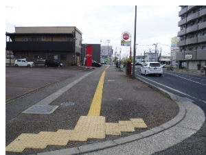
写真 37 視覚障害者誘導用ブロックの設置
