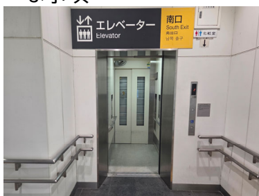
写真 33 エレベーターの設置
