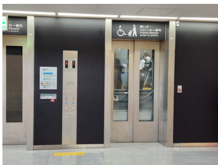
写真 42 車椅子使用者対応エレベーターの設置
