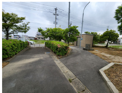
写真 40 園路の段差解消
