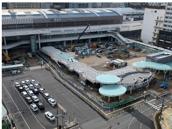
写真1 JR新潟駅(整備中)
