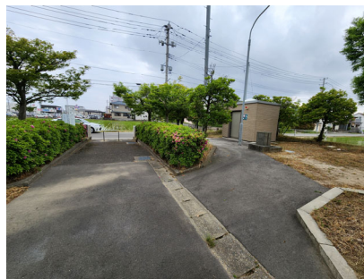
写真 40 園路の段差解消
