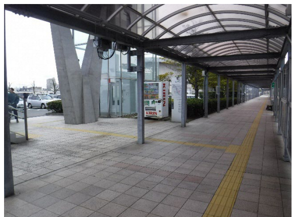
写真6 朱鷺メッセ付近の歩道
