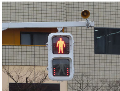
写真44 音響式信号機の設置
