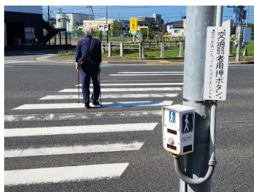
写真 45 青延長用押しボタン付き 信号機の設置
