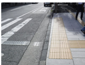
写真 36 車道との段差解消
