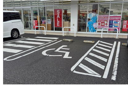
写真 39 車椅子使用者駐車区画の整備
