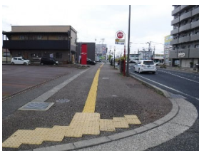
写真 37 視覚障害者誘導用ブロックの設置
