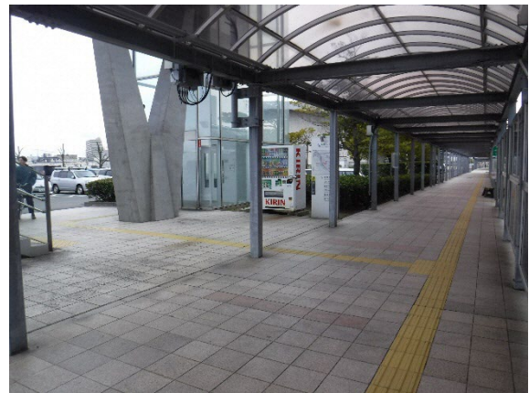
写真6 朱鷺メッセ付近の歩道
