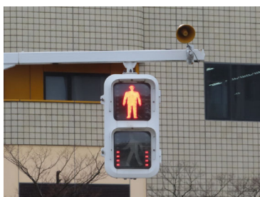
写真44 音響式信号機の設置
