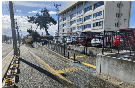
写真12 坂井輪地区公民館
