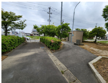
写真 40 園路の段差解消
