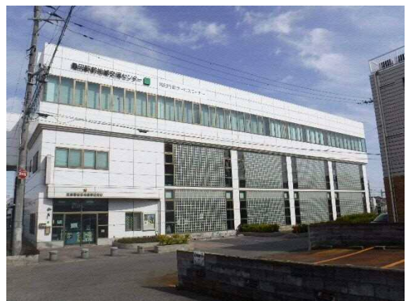
写真 6-27 亀田駅前地域交流センター
