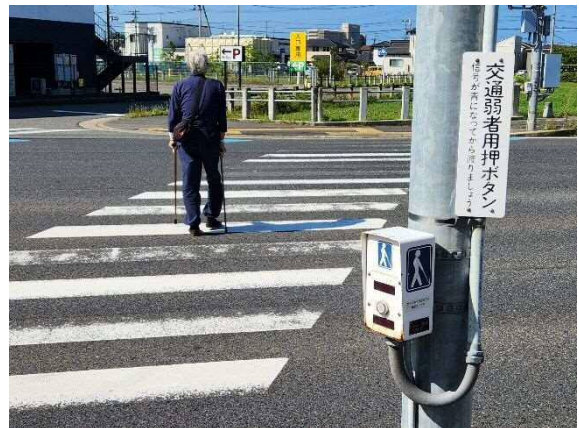
写真 2-8 青延長用押ボタン付き信号機
