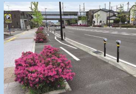
整備後の新潟鳥屋野線 (2020年3月)
