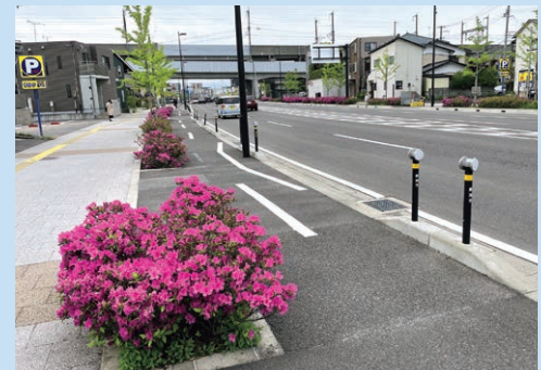
整備後の新潟鳥屋野線 (2020年3月)
