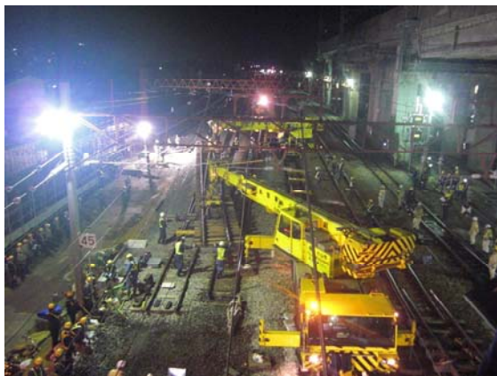
クレーンによる切換工事の状況 ①
