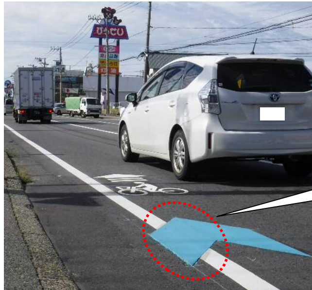
図6-7. 矢羽根型路面表示と外側線が重なる場合
