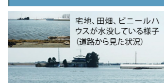
津波による低平地浸水 平成23年東日本大震災 宮城県亘理町
