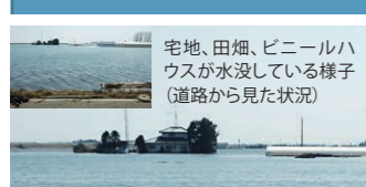
津波による低平地浸水 平成23年東日本大震災 宮城県亘理町
