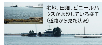
津波による低平地浸水 平成23年東日本大震災 宮城県亘理町
