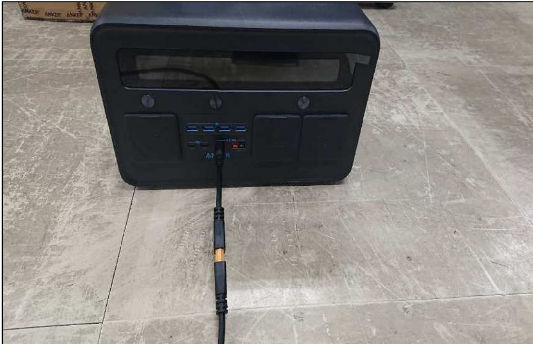
⑦ もう一方の端子を蓄電池へ接続します。
