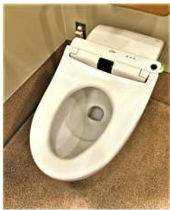
水が流せないトイレ
