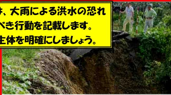
H23.7 新潟・福島豪雨時の角田山麓の法面が崩壊している様子
