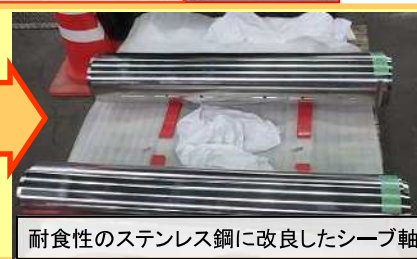
新潟大堰 主ゲート ワイヤロープシーブ(滑車)の交換
