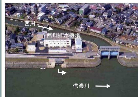
西川排水機場
