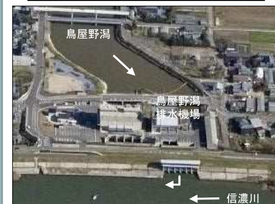
鳥屋野潟排水機場
