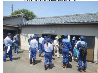
新潟市濁川水防倉庫
