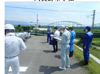
阿賀野市下里（羽越本線鉄橋）
