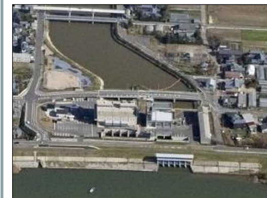
鳥屋野潟排水機場
