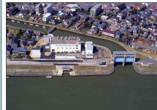
西川排水機場
