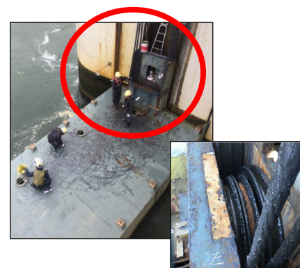
塩害による腐食の影響がある部品の更新を行う。
