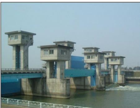
中ノロ川水門調節ゲート 塗替塗装・主ローラ等の交換
