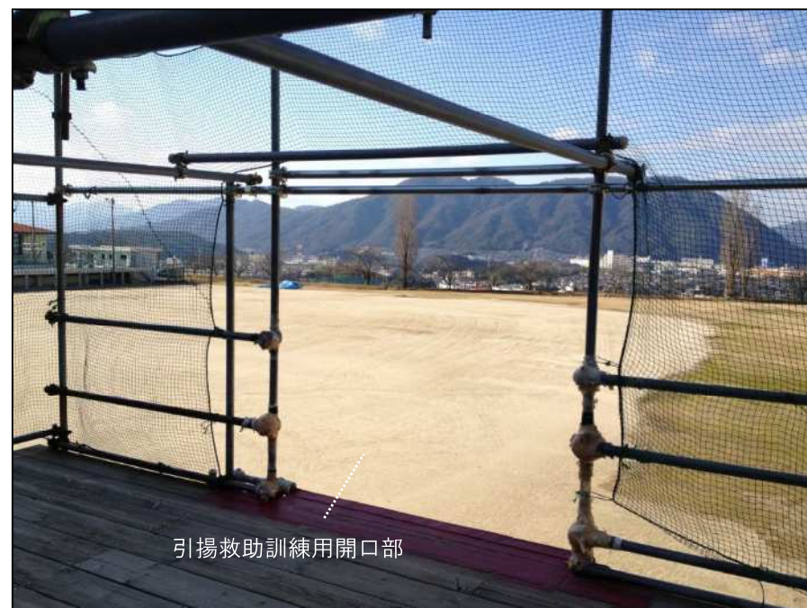
写真 12「引揚救助用支点鉄骨（開口部）」
