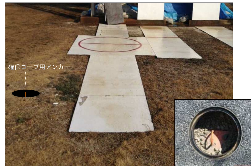
写真7 「A塔確保ロープ用アンカー位置」
