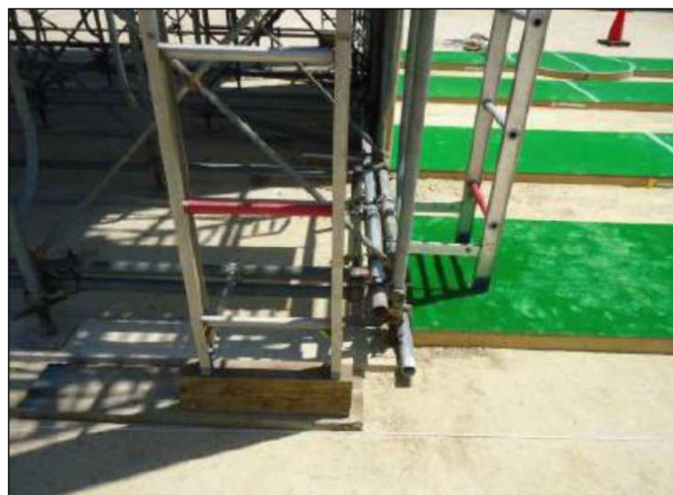
写真8 「はしご設置状況」
