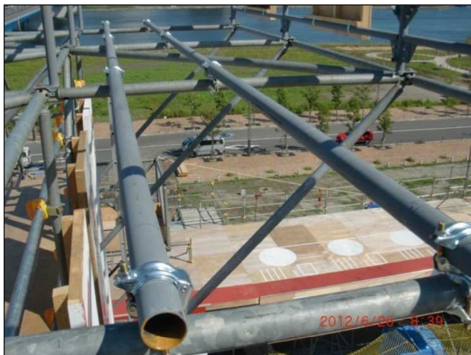
写真6 「A塔懸垂線用アンカー」
