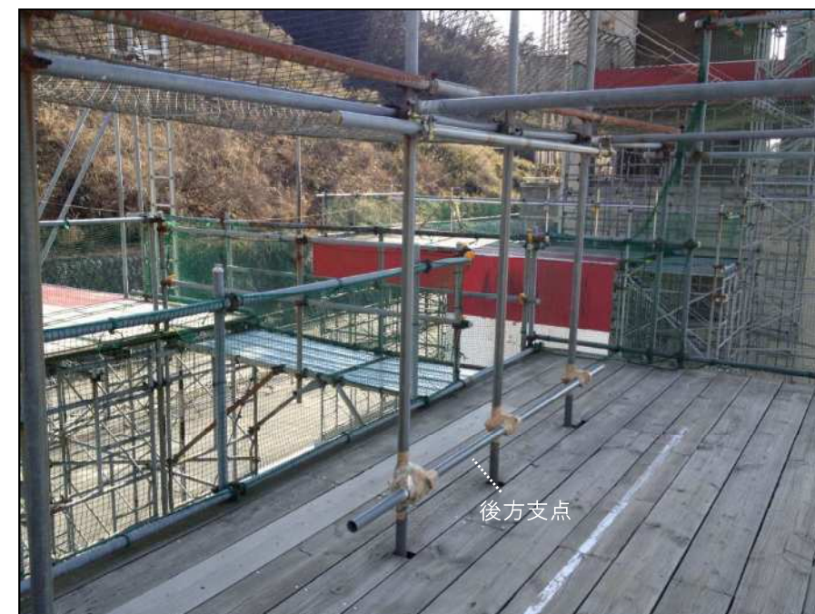
写真 13「引揚救助用支点鉄骨（後方支点）」
