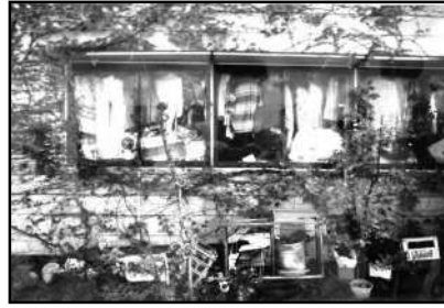
「廃墟」 横山サチ子(新保) 窓際に洋服がびっしり掛けてあり人が住んでいる様に見えますが廃墟です。
