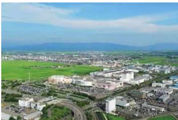
亀田工業団地
