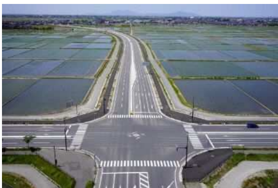
新潟中央環状道路 横越バイパス
