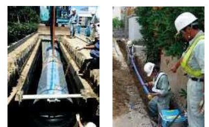
耐震管への更新工事
