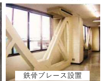
下水処理場の耐震化
