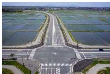
新潟中央環状道路 横越バイパス
