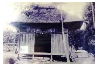
昭和 15 年建替え前の写真
